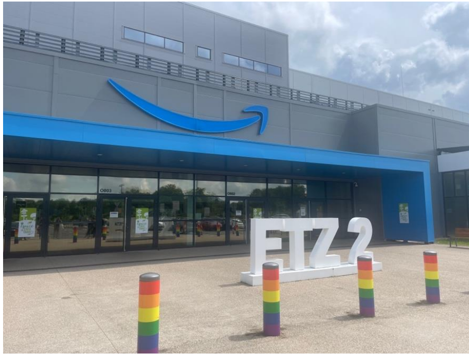
Figure 10. Extérieur de l'entrée principale de l'entrepôt ETZ 2 (Besnard, 2024).
