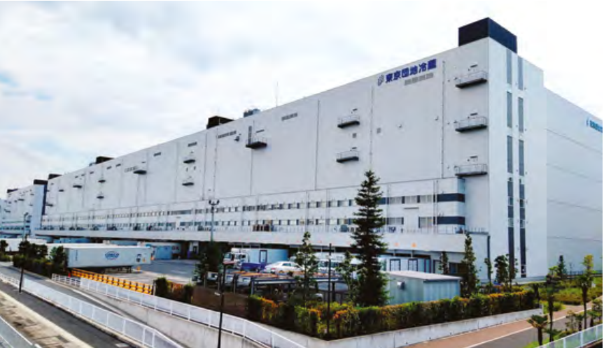
Entrepôt à étages dans le cœur de l’agglomération de Tokyo : Tokyo Danchi Reizo.
