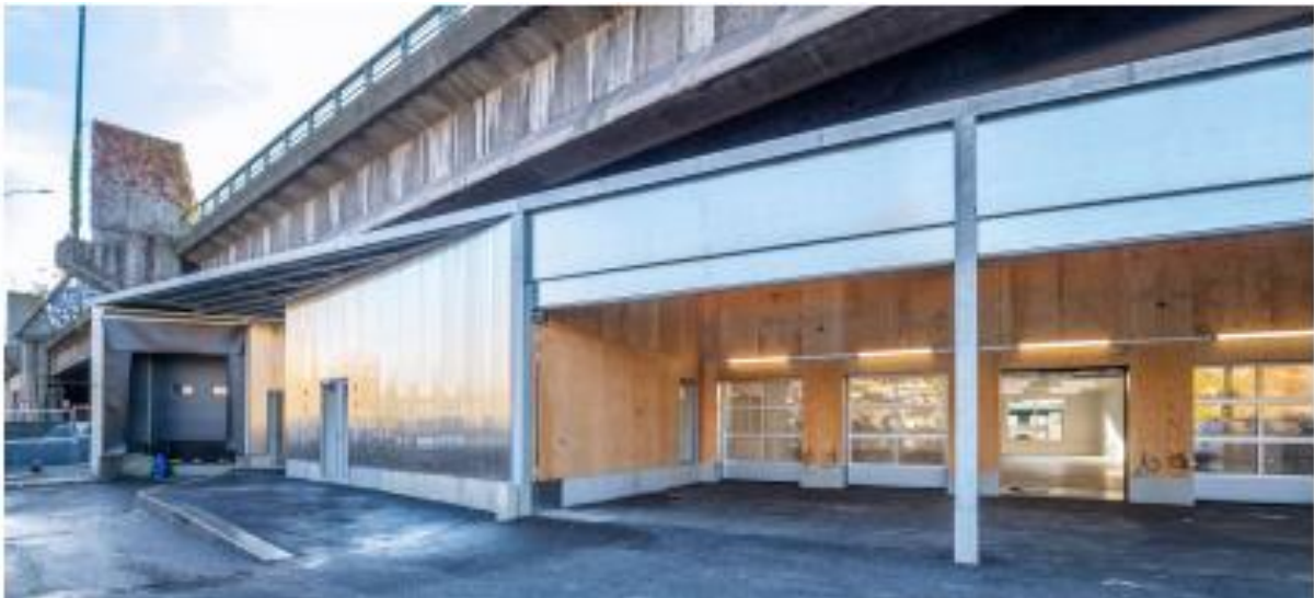
Figure 1 : Site de P4 – 19e arrondissement de Paris. Lauréat du prix MIPIM 2021. Source : Sogaris
